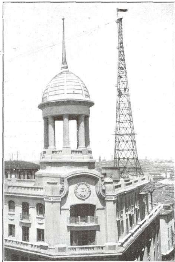
La antena de la «Unión Radio» instalada en la terraza de uno de los mejores edificios de la Gran Vía
