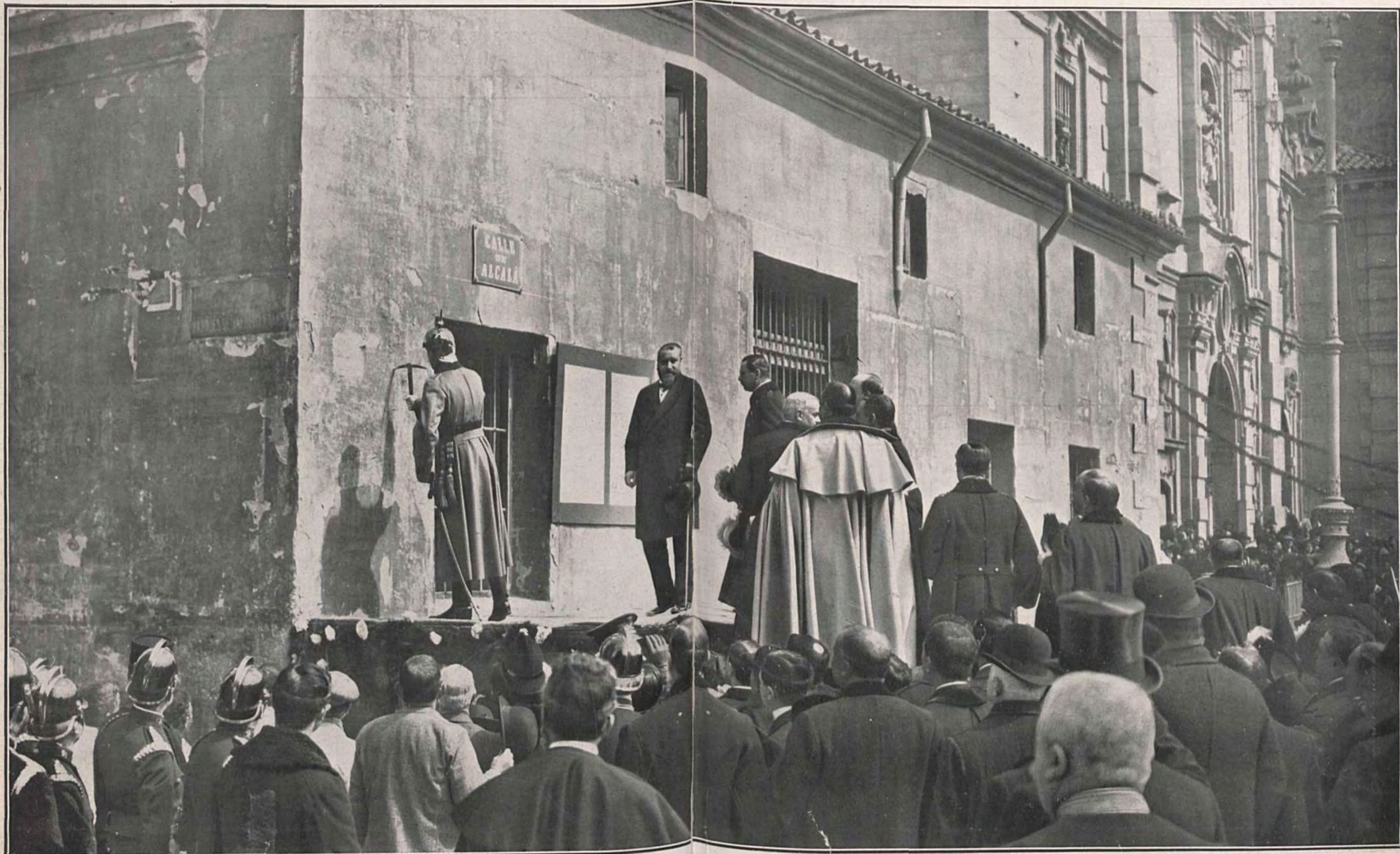
Momento solemne de iniciar el Rey con un golpe de piqueta el derribo de la casa rectoral de San José, primer edificio que será demolido para la construcción de la Gran Vía
